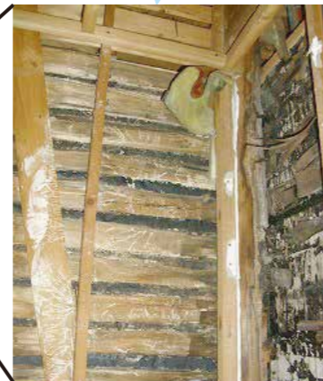
壁の中の様子
