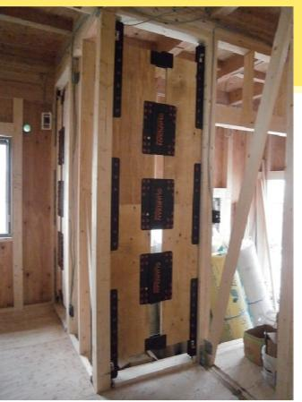
←まずは構造躯体、耐震等級3に加え、制震ダンパーの設置でさらに地震力を吸収軽減致します。4箇所設置。
